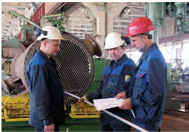
Бригада слесарей ремонтно-механического производства.
